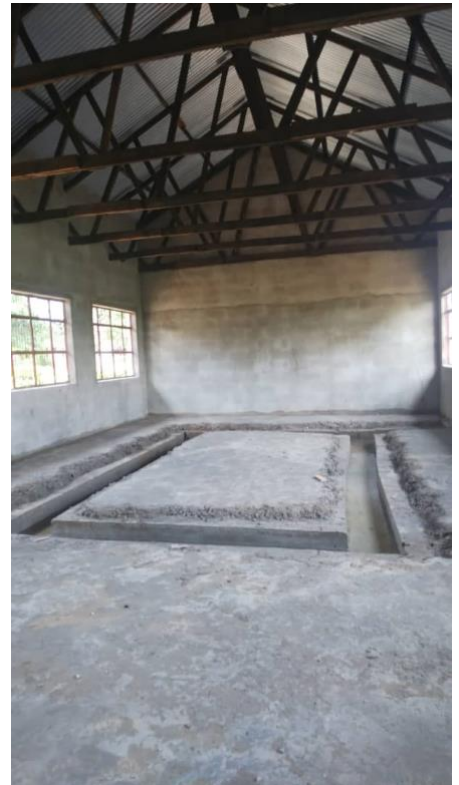
Laborraum rechts vorbereitet für Wasser und Elektrizität,
